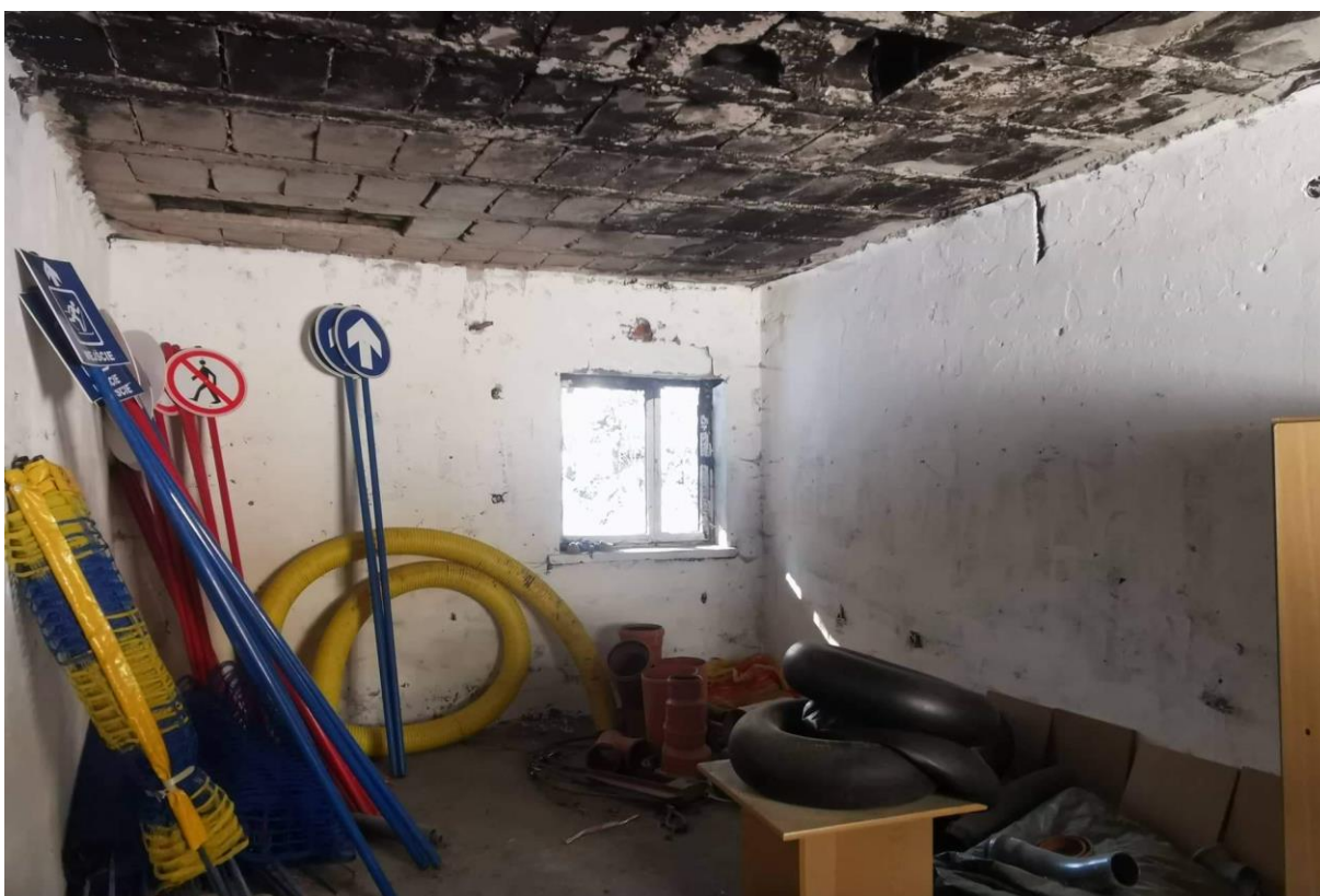
Fot. 7 Pomieszczenie w części południowo-wschodniej budynku źródło: Urząd Gminy Kościelisko
