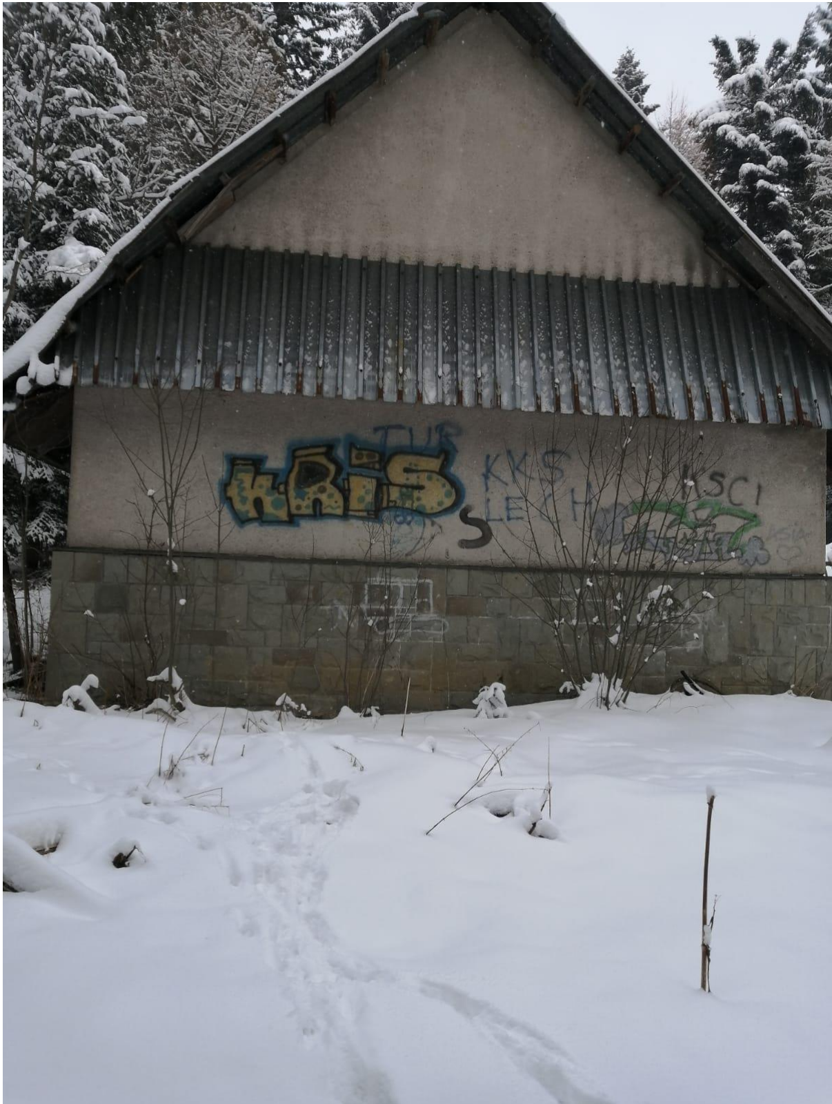
Fot. 5 Elewacja boczna budynku (od strony południowo-wschodniej) źródło: Urząd Gminy Kościelisko
