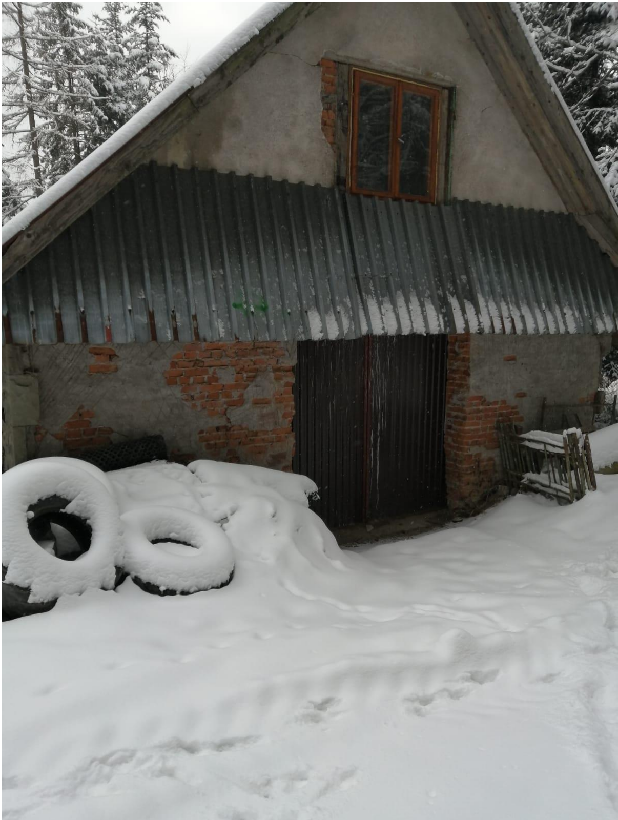
Fot. 4 Elewacja boczna budynku (od strony północno-zachodniej) źródło: Urząd Gminy Kościelisko
